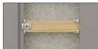
2. attēls Swisspearl Connect klipsis
