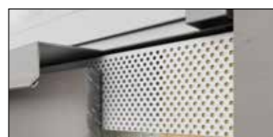
8. attēls Swisspearl ventilācijas profils
