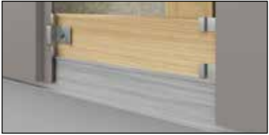
6. attēls Swisspearl Plank Connect vertikālais sākuma profils
