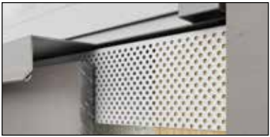
8. attēls Swisspearl ventilācijas profils
