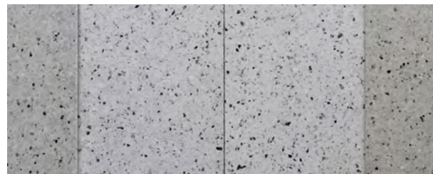
Stoß mit abgeflachten Kanten
