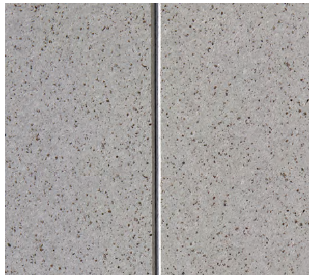
Stoß mit abgeschrägten Kanten
