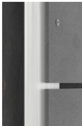
Otevřené spáry
