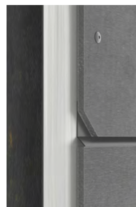
Spára osazená profilem
