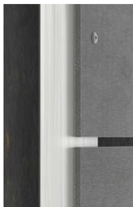
Otevřené spáry
