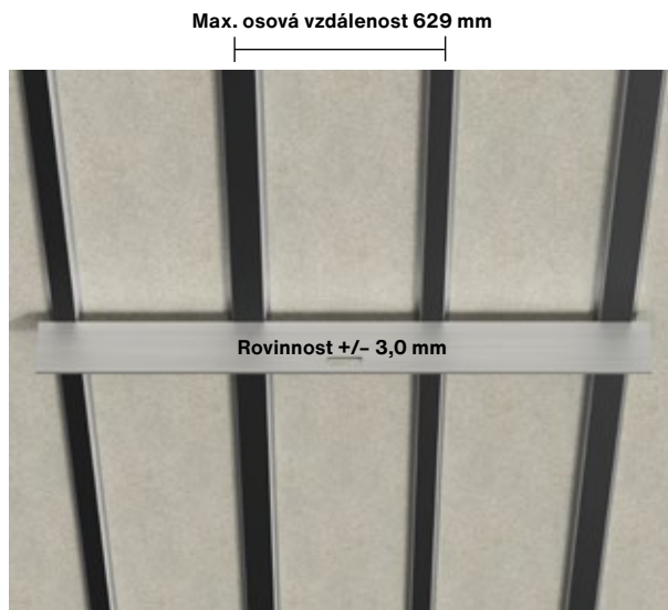
Rovinnost podkladní konstrukce
