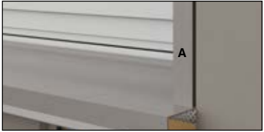
Billede 5 Swisspearl Udvendigt Hjørne, lille, monteret ved vindue
