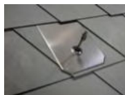
Einbau bei ED Rhombus 400x440
