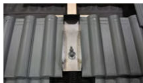
Die weiteren Dachsteine beidecken
