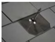
Einbau bei DD Rechteck 300x400
