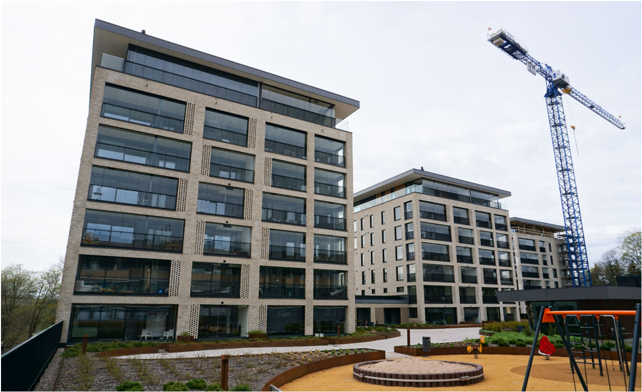
Swisspearl julkisivulevyt asennettuina parvekkeiden seinä- ja kattopintoihin.
