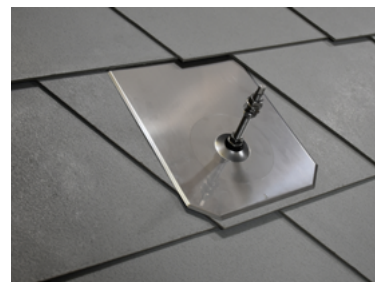
Einbau bei DD Rechteck 300x400 Einbau bei ED Rhombus 400x440
