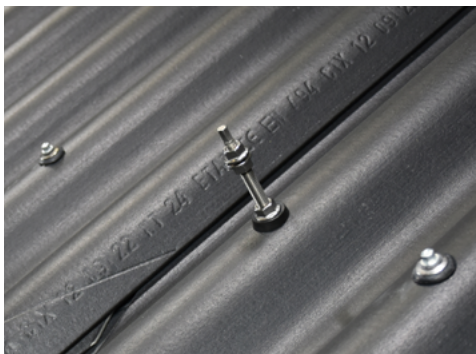
Stockschraube bei Wellplatte
