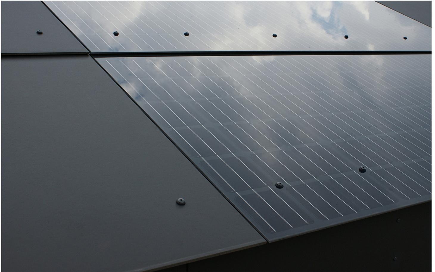
Insgesamt 140 Quadratmeter Photovoltaik-Dach auf Haus und Carport erzeugen bei diesem Haus 18.000 kWh-Umweltstrom. Das innovative Swisspearl Energiedach ist durch die plan in die Fläche eingearbeiteten Solarelemente überaus ästhetisch.
