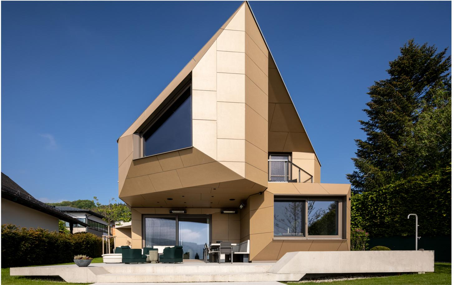
Für Gestaltung der Fassade wurde die Fassadenplatte Largo von Swisspearl gewählt. Der dynamische Herstellungsprozess verleiht Avera seine unvergleichliche, natürliche Textur. Die Rohmaterialien werden im Prozess wie in einem reißenden Fluss vermengt und bilden dabei das ausgeprägt lebendige Oberflächenbild. Die daraus entstehende Variierung von Textur und Farbtonalität betont die Authentizität des mineralischen Werkstoffs zusätzlich.
