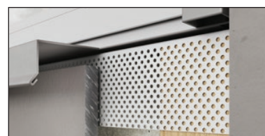
Illustrasjon 8: Swisspearl ventilert profil
