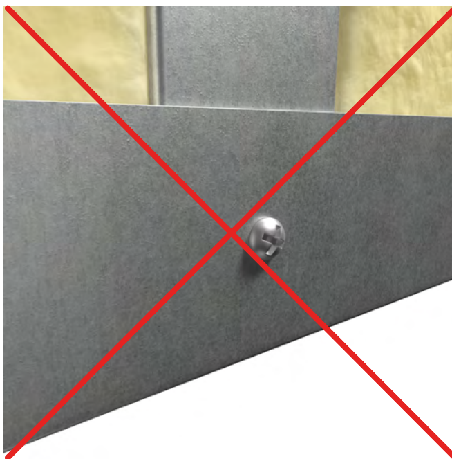
Het gebruik van schroeven met te dikke koppen moet worden vermeden.
