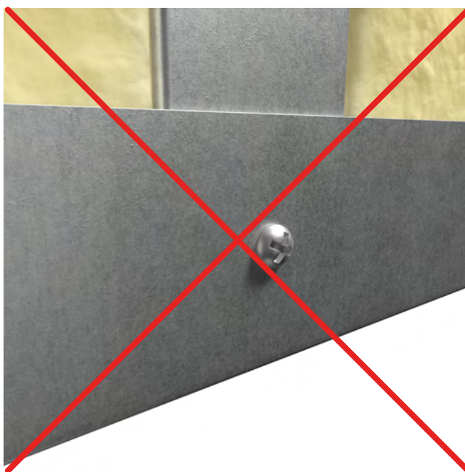
Bruk av skruer med for store hoder må unngås.
