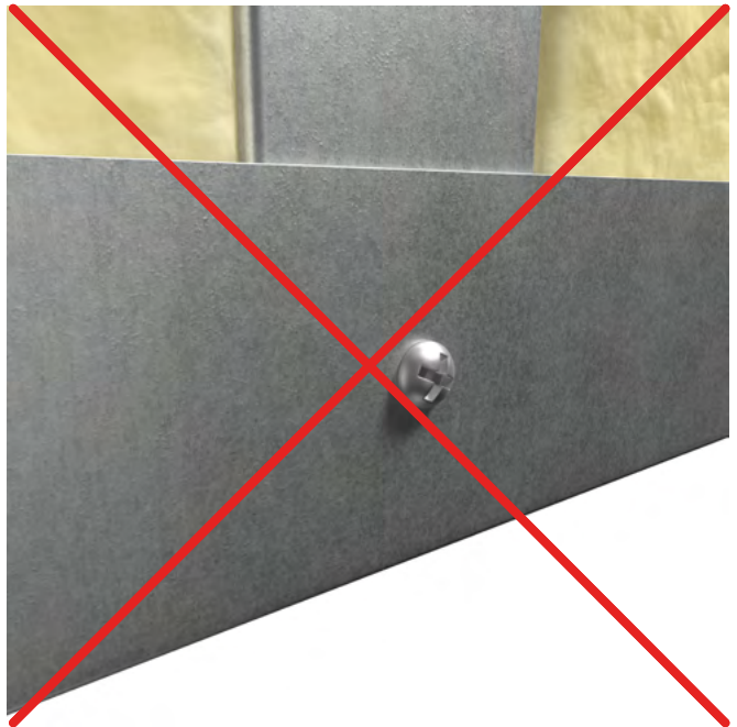
Liian suurikantaisten ruuvien käyttöä on vältettävä.
