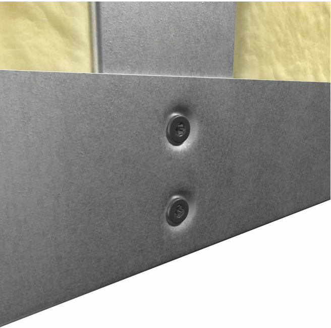
Het is handig om in de stalen profielen verzonken gaten te maken voor de schroeven, zodat de schroefkoppen niet uitsteken.
