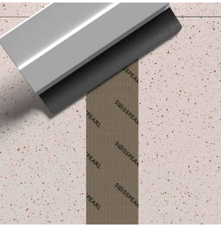
Gebruik de spatel om de tape glad te strijken voor de beste hechting
