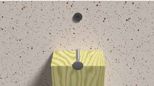
Zorg ervoor dat je bij de latten in het midden de nagels niet te dicht bij de rand van de onderliggende constructie plaatst
