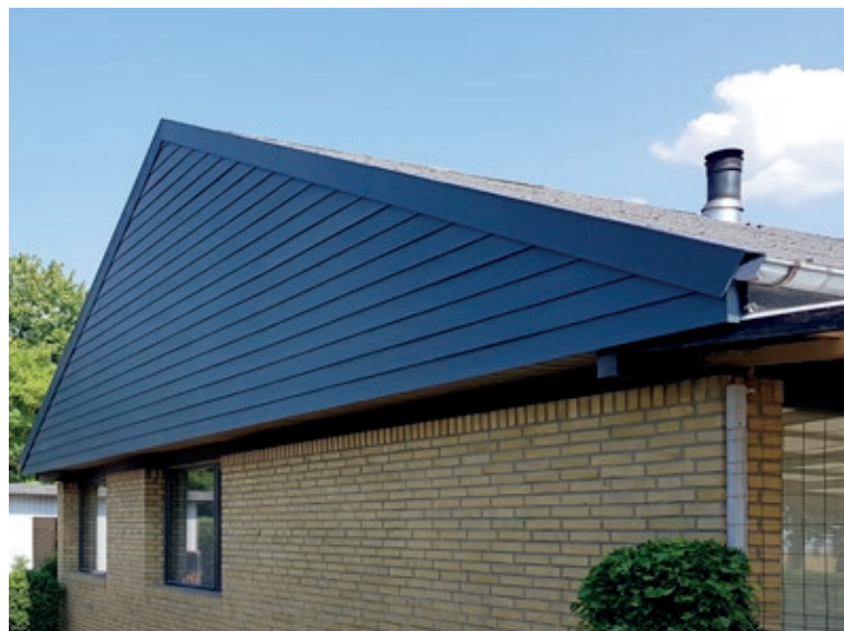
Nach der Renovierung
