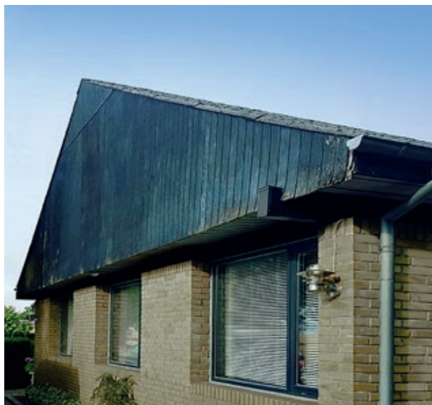
Vor der Renovierung
