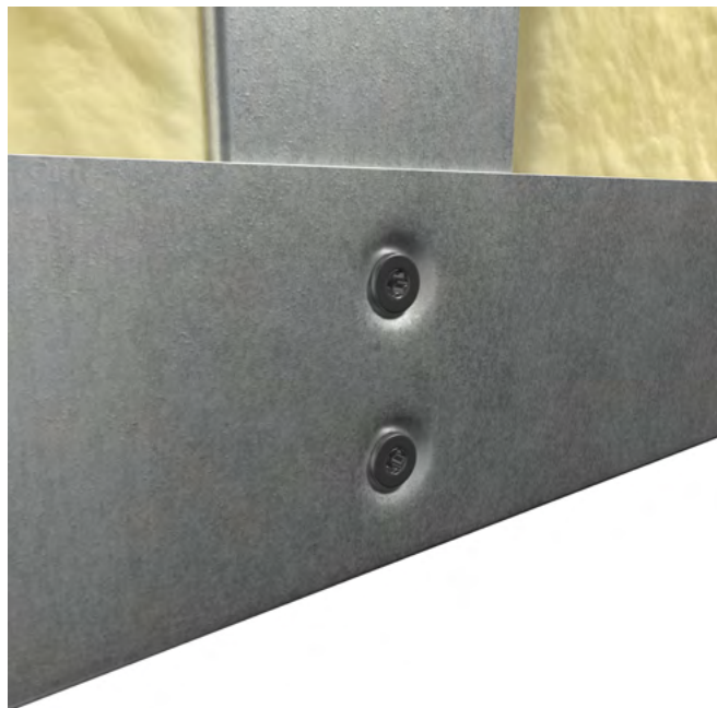
Tērauda profilos ir ieteicams izveidot skrūvju iegremdēšanas vietas, lai skrūvju galvas neizvirzītos.
