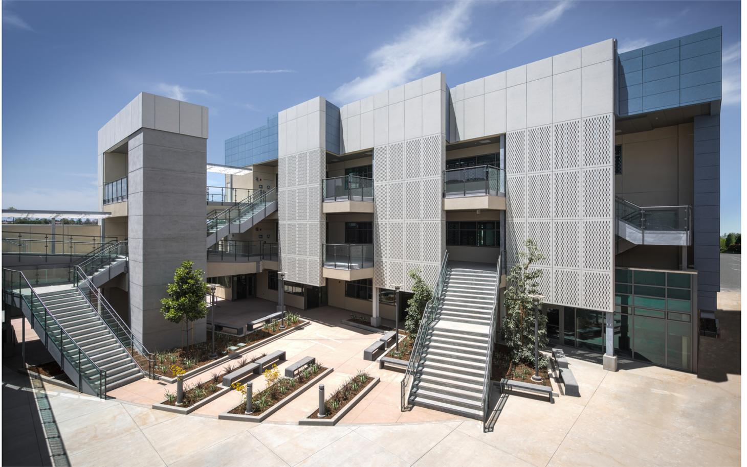
Als integraler Bestandteil einer umfassenden Nachhaltigkeitsstrategie, die auf eine LEED-Gold-Zertifizierung abzielt, entwarfen die Architekten eine mit Swisspearl Paneelen verkleidete Regenschutzfassade, die die Energieleistung des Gebäudes verbessert und dazu beiträgt, die langfristigen Wartungskosten auf ein Minimum zu reduzieren.
