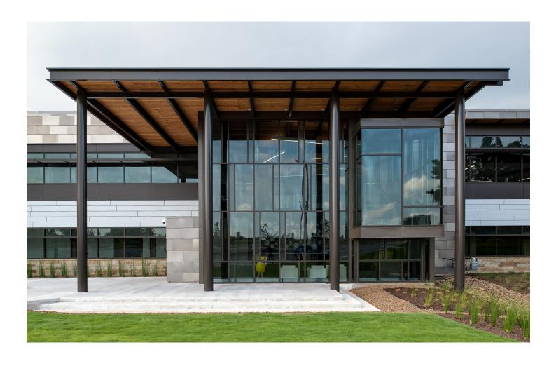
Das Neptune Office Building ist in langen, parallelen Linien aus geschichteten Materialien: Stein, Verglasung, Swisspearl-Paneele und Stahlverkleidungen in dicht gepackten, sich überlappenden Paneelen. Ineinander greifende Formen ragen aus der Fassadenhülle, die von einem holzverkleideten Traufüberstand überdeckt wird, der den Außenbalkon im Obergeschoss schützt.
